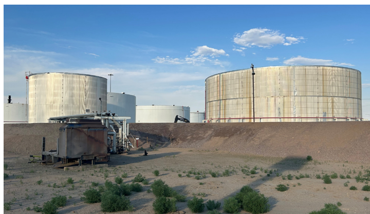
La refinería de Suncor en Commerce City con una pared de contención secundaria de tierra elevada alrededor del área del tanque de almacenamiento.
